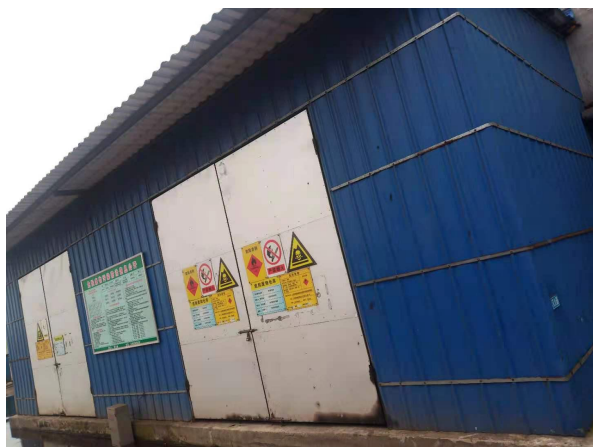
危险废物暂存间
