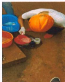
400 泊位污水站清水池
