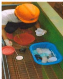
22 泊位污水站清水池
