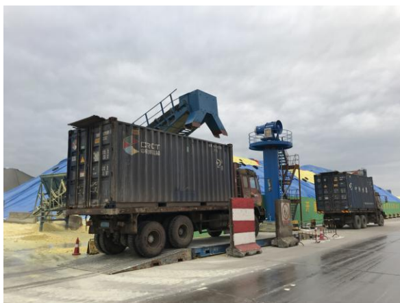
14#硫磺堆场（挡墙+苫盖+雾炮机）
