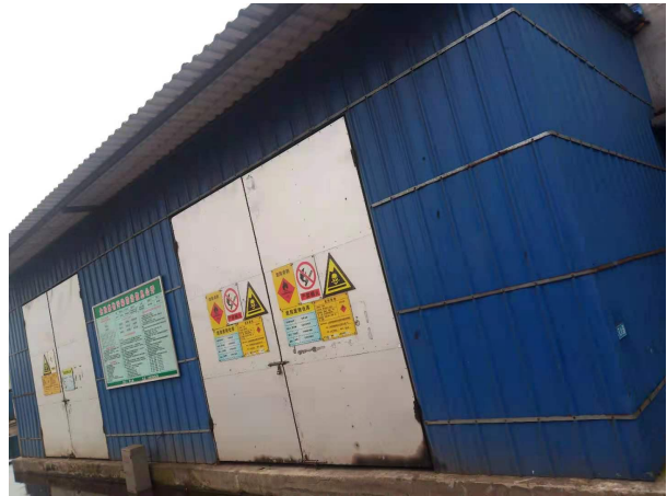
危险废物暂存间
