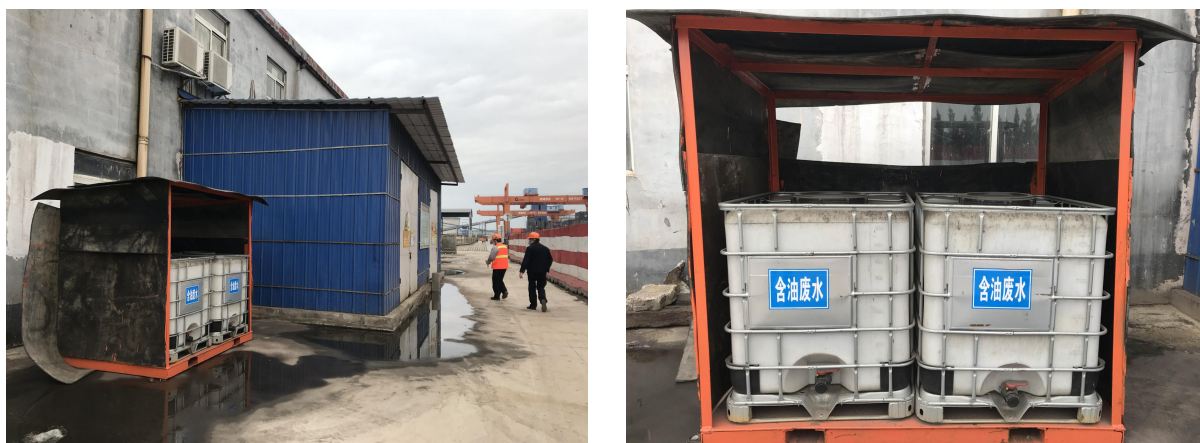
图 5.2-4 机修车间含油废水暂存间现场照片
