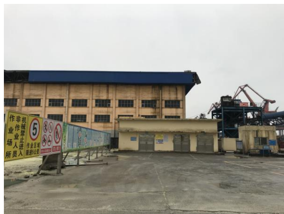
第 15 泊位含磷污水处理站
