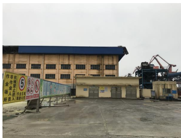
15#泊位含磷污水处理站
