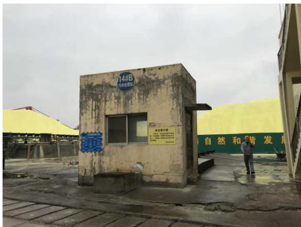
14#泊位生活污水处理站
