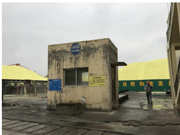
第 14#泊位生活污水处理站
